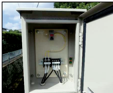
モニタリングボックス設置
