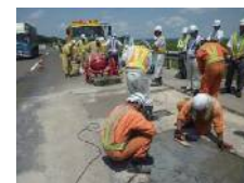
⑤PDモルタル打設
