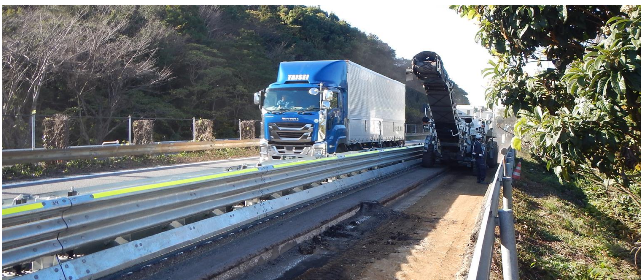
東名高速道路 路肩舗装改良工事でのバルカンバリア
